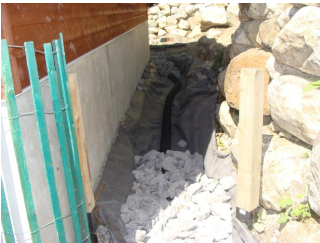
Construction de la fosse de drainage constituée d'une toile géotextile et de gravier de 5" de diamètre. Photos : Pierre Lefebvre
