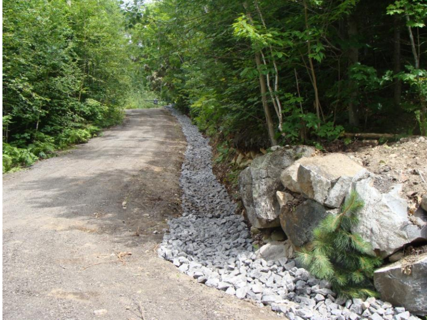
Fossé de drainage ralentissant l'écoulement des eaux de pluies et de fonte des neiges. Photo : Pierre Lefebvre
